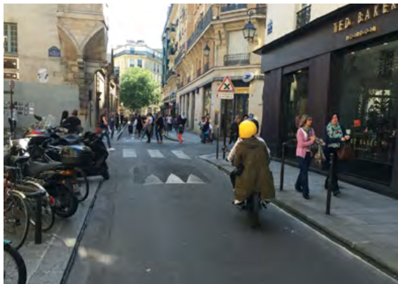
Figura 3.2 | Caso de almofada redutora de velocidade
