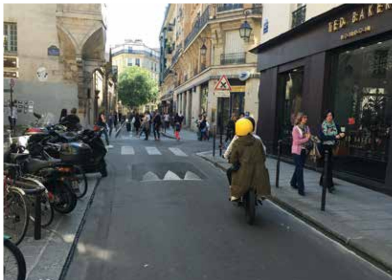
图 3.2 | 减分段式减速带案例
