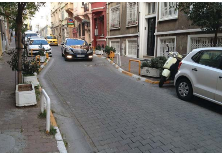
รูป 3.3 | ตัวอย่างจุดชะลอความเร็วแบบเบี่ยง
