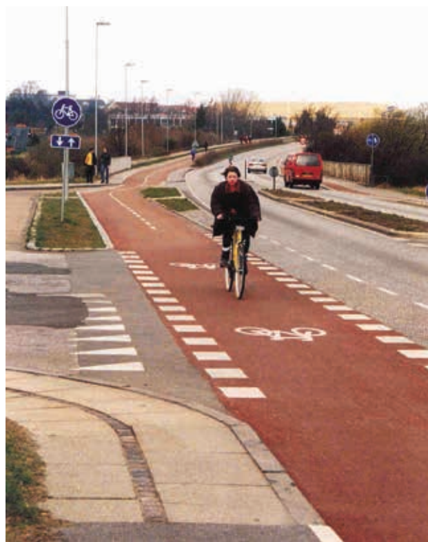
Рисунок 32 Пример использования знаков и разметки велосипедной дорожки
