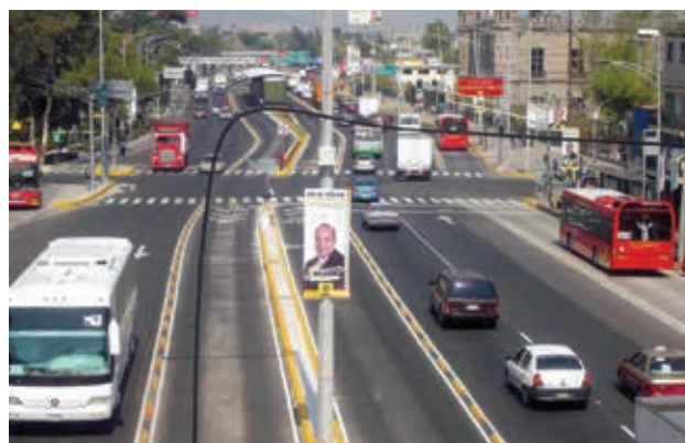
Рисунок 86 «Eje 3 Oriente» после реализации изменений, полосы системы БРТ для 5-й линии «Metrobús» и улучшенная пешеходная инфраструктура
