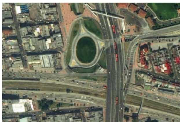
Рисунок 74 Развязка для трех коридоров системы БРТ «TransMilenio»: NQS, Calle 80 и Avenida Suba. Автобусное соединение трех коридоров осуществляется через надземные и подземные проезды, что максимально повышает пропускную способность всех маневров и сводит к минимуму потенциальные конфликты между автобусами.
