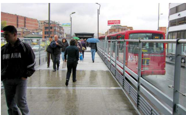
Figura 55 TransMilenio 2011: os gradis ao longo da ligação foram elevados para que seja mais difícil escalá-los. Recomenda-se o uso de gradis mais altos em trechos que conectam diferentes módulos de uma mesma estação.
