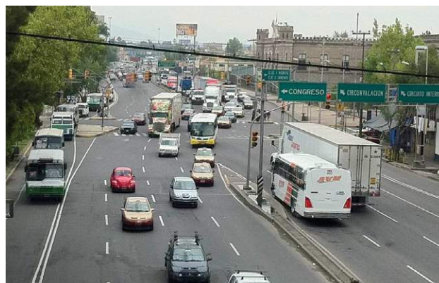
Figura 85 Eje 3 Oriente Eduardo Molina antes da intervenção, mostrando a configuração de contrafluxo e uma troca no sentido de circulação
