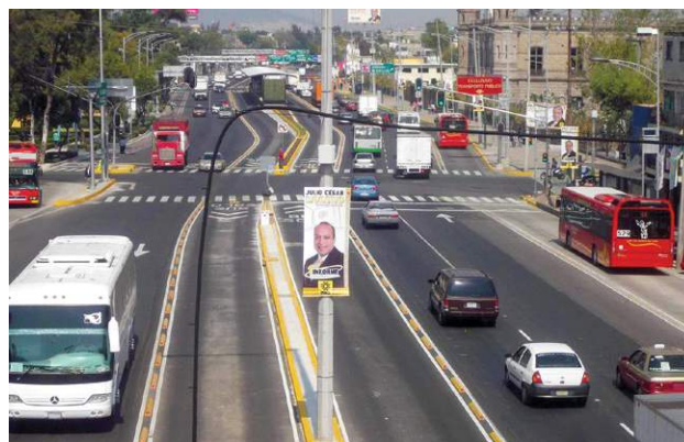
Figura 86 Eje 3 Oriente após a intervenção, mostrando as faixas de BRT da Linha 5 do Metrobús e a infraestrutura melhorada para pedestres
