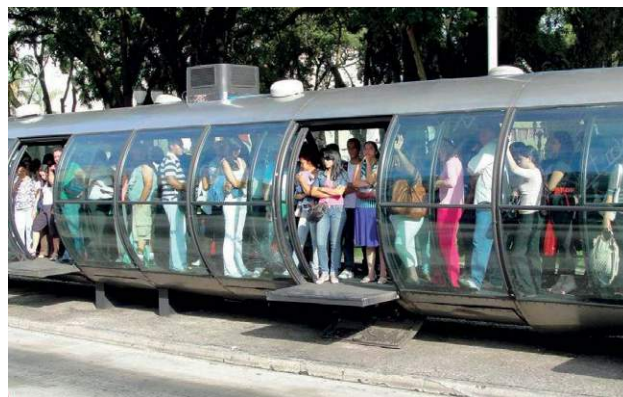
Figura 53 Porta automática em uma estação BRT em Curitiba. As portas estão abertas, embora não haja nenhum ônibus na estação. Isso é um risco em uma estação lotada, já que os passageiros podem cair acidentalmente nas faixas de ônibus.
