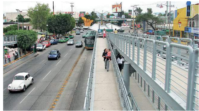
Figura 13 Passarela com rampa e área para descanso em León, México
