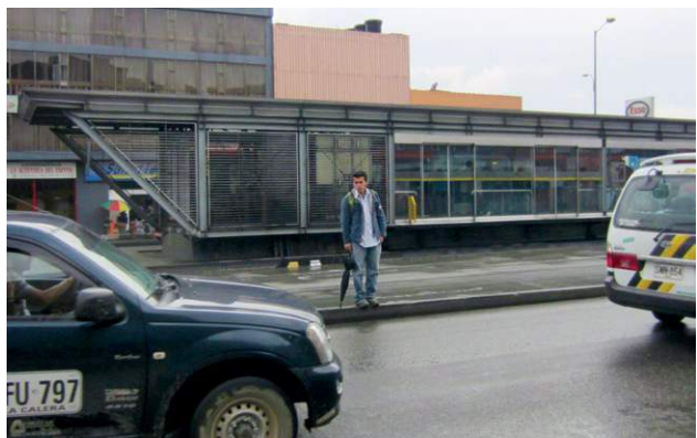
Figura 52 Pedestre atravessando a via em frente à estação, sem barreiras entre a faixa de ônibus e as faixas de tráfego misto
