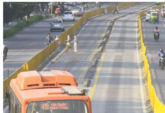
Figura 8 Pedestres atravessando o corredor BRTS de Delhi em meio de quadra
