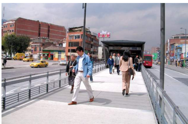
Figura 54 TransMilenio 2006: uma ligação entre dois módulos em uma mesma estação. Observa-se que os gradis baixos, de aproximadamente 1 m de altura, permitem que as pessoas pulem por cima facilmente, um importante risco à segurança dos pedestres.
