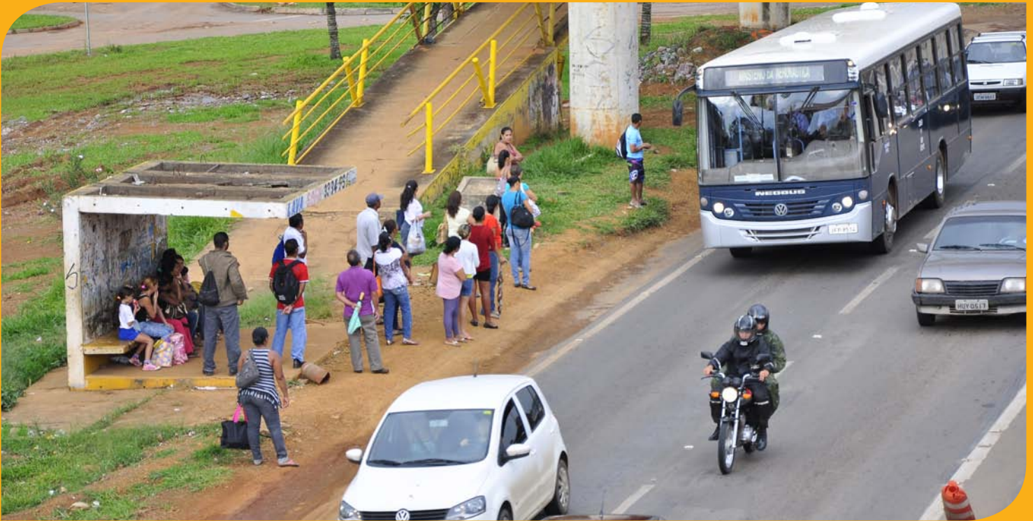
Dịch vụ xe buýt và cơ sở hạ tầng thông thường tại Brasilia
