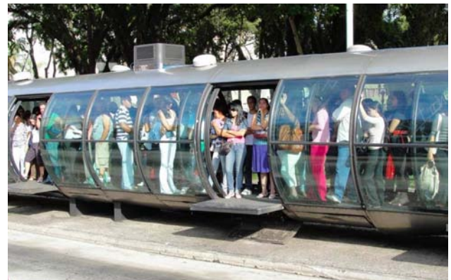
Hình 53 Cửa chặn tại một bến BRT ở Curitiba. Cửa được mở ra, ngay cả khi không có chiếc xe buýt nào xuất hiện. Đây là một rủi ro về an toàn tại một bến đông người, khi hành khách có thể ngã xuống làn đường xe buýt.
