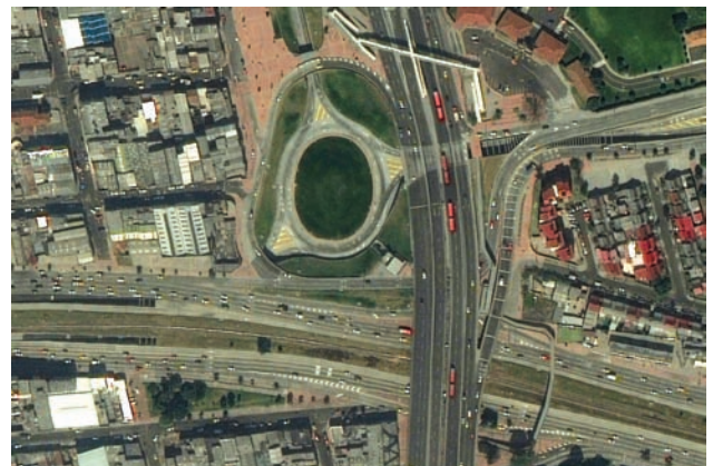
Hình 74 Lối giao nhau giữa ba tuyến TransMilenio: NQS, Calle 80, và Avenida Suba. Kết nối xe buýt giữa ba tuyến được thực hiện qua cầu vượt và hầm, tối đa hóa việc thực hiện các chuyển động và giảm thiểu những va chạm tiềm ẩn giữa xe buýt.
