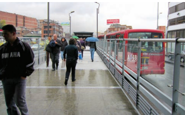
Hình 55 TransMilenio 2011: Lan can dọc theo con đường đã được nâng lên khiến mọi người thấy khó khăn hơn khi trèo qua. Chúng tôi khuyến nghị sử dụng loại lan can cao hơn cho các lối đi nối các khu vực khác nhau của cùng một bến.
